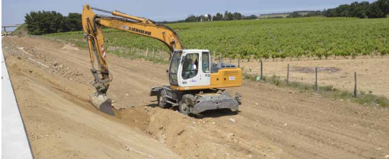
LA PELLETEUSE FINALISE LES TALUS POUR QU'ILS SOIENT RÉGULIERS
