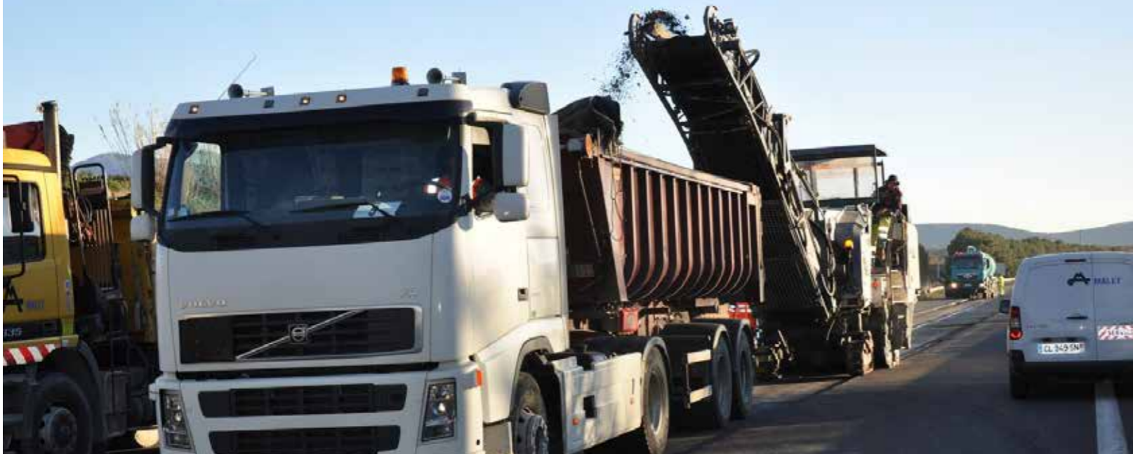
DÉCAPAGE DE L'ENROBÉ EXISTANT
