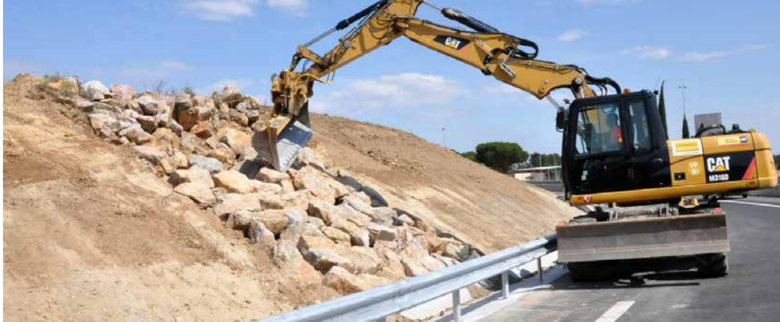
PARFOIS, ON RÉALISE UN ENROCHEMENT POUR MIEUX TENIR LES TALUS
