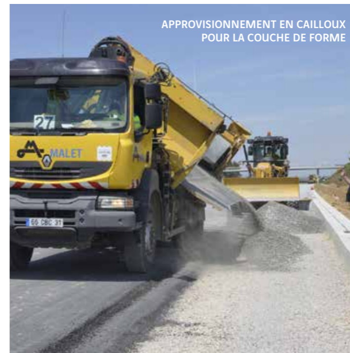
LA NIVELEUSE ÉTALE LES MATÉRIAUX AU NIVEAU DE L'ENROBÉ QUI A ÉTÉ PRÉALABLEMENT DÉCAPÉ
